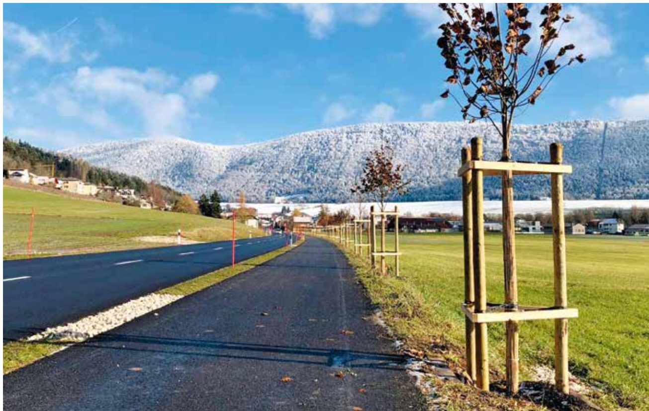
Un exemple d'aménagement du territoire: une route principale, une piste cyclable et une allée d'arbres, caractéristique paysagère du Val-de-Ruz (photo pif).
